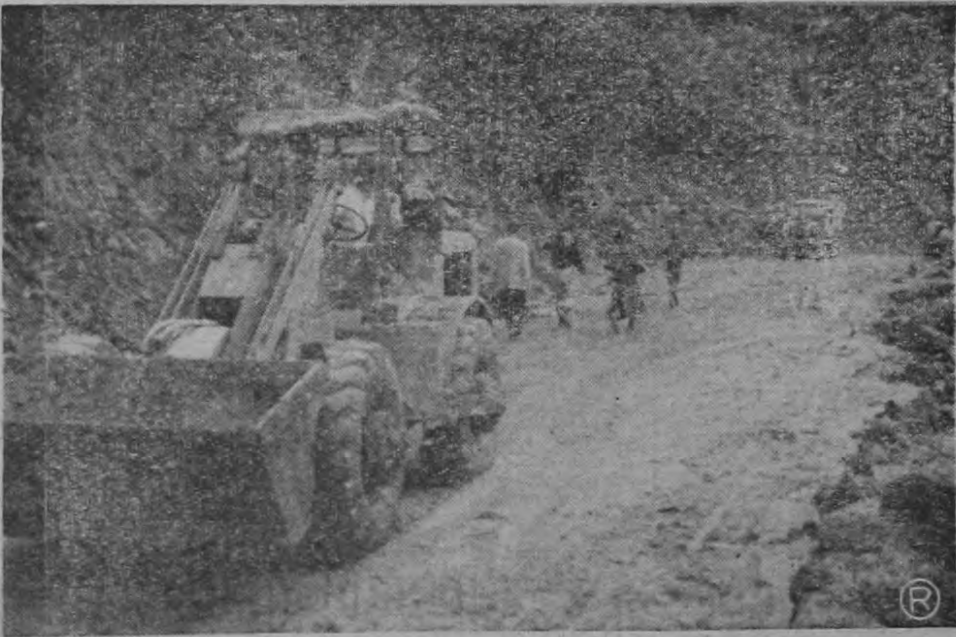
TRABAJANDO EN ASERRI. — Notese en esta gráfica el equipo del Ministerio de Obras Públicas en actividad, despejando la carretera de Aserrí de los derrumbes que le cayeron con motivo de los últimos temporales.
