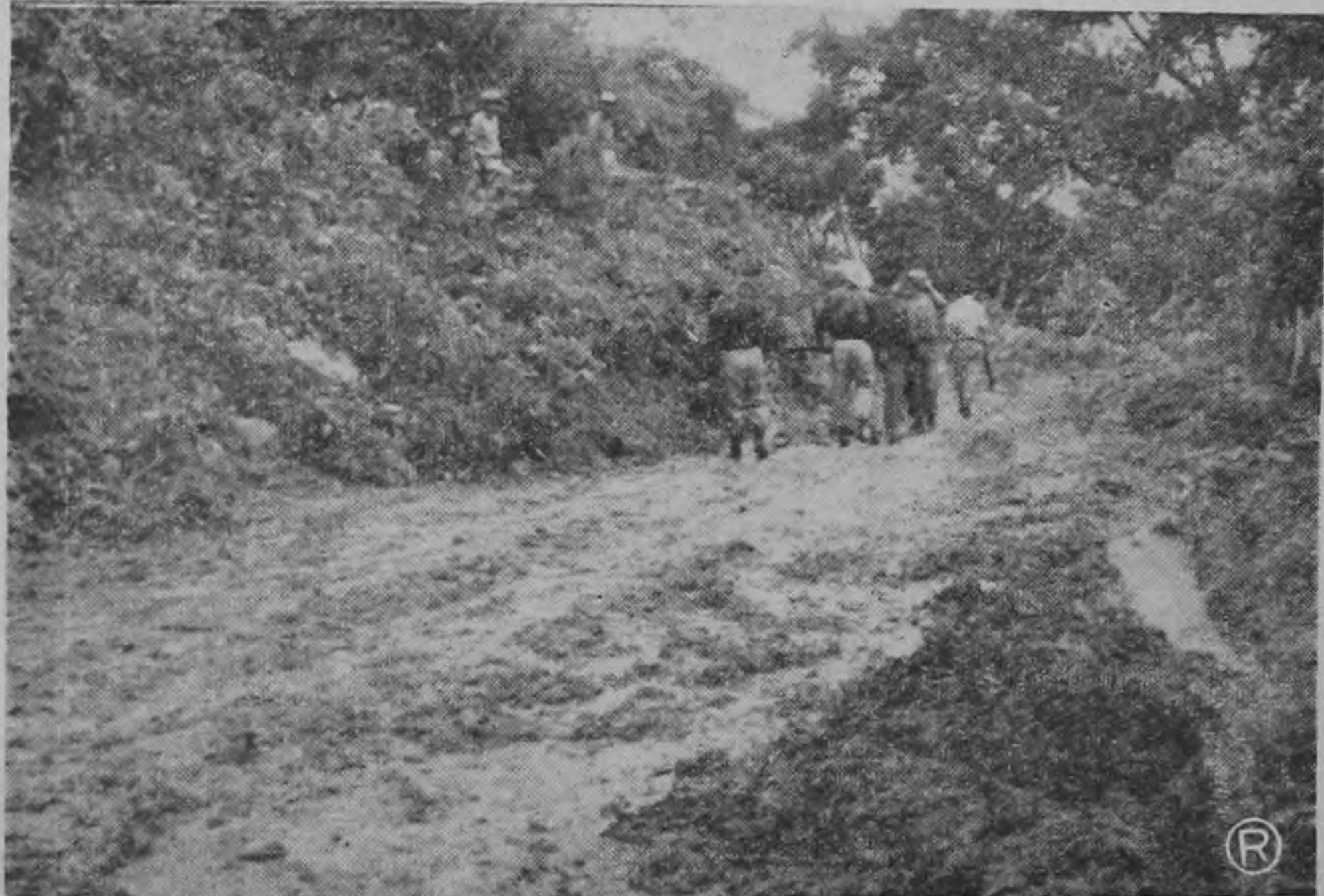
ABRIENDO LAS CARRETERAS. — Esta vía de Aserrí, había quedado intransitable con motivo de las inundaciones y derrumbes. Cuadrillas de Obras Públicas, con el equipo necesario, trabajaron arduamente habiéndola reabierto en corto lapso.
